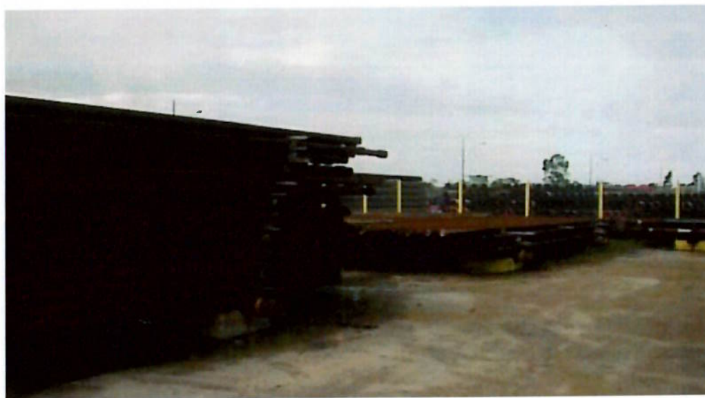
FIGURA 04 – Marimbondo, outra vista da área destinada a armazenamento de tubos.
